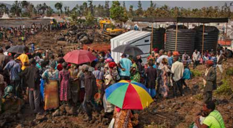
Installation av vattenanläggning i Kongo-Kinshasa. BILD ALEXANDRE MARCOU
